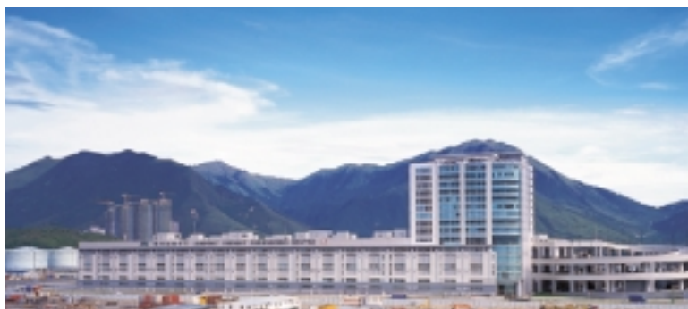
機場空運中心位於香港國際機場，享盡地利。
