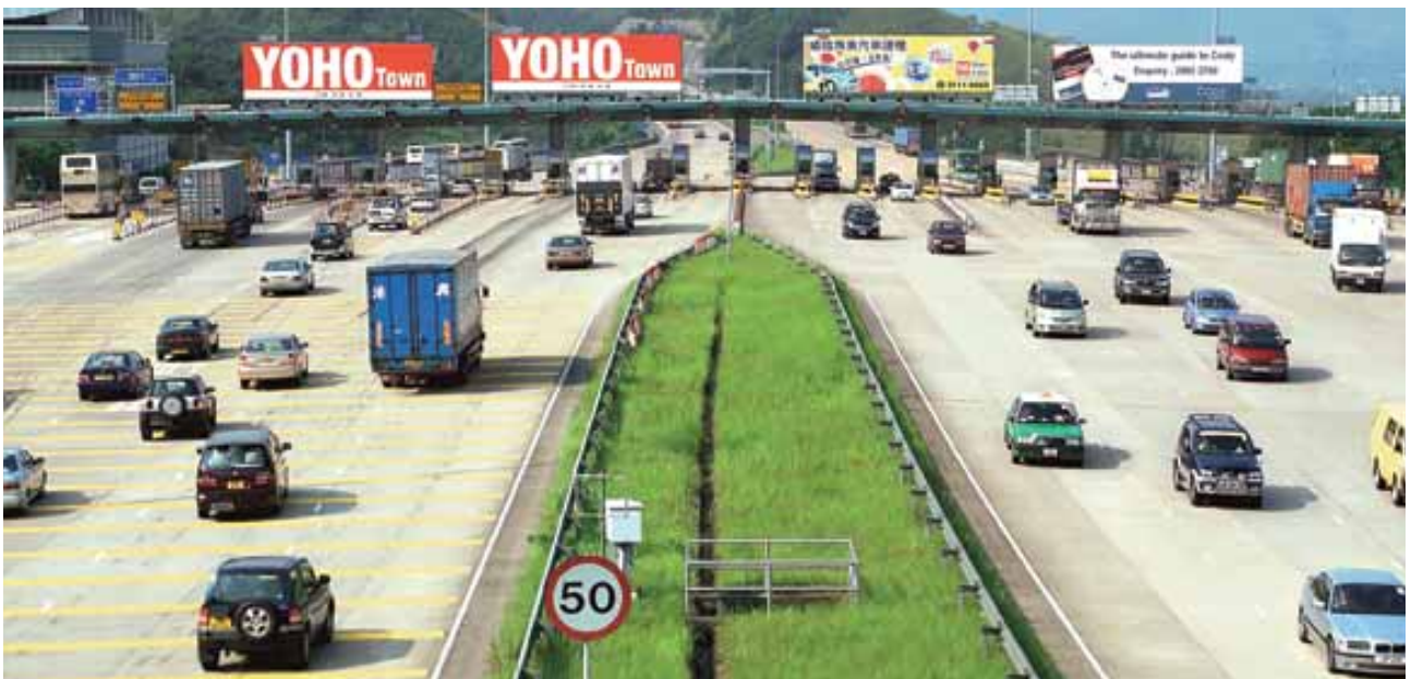
三號幹線（郊野公園段）是連接新界西北與九龍市區的重要高速幹線。
