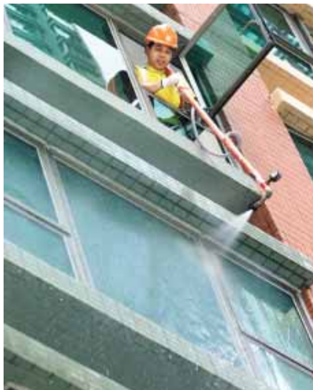
新落成物業的窗戶均經高壓水槍測試。
