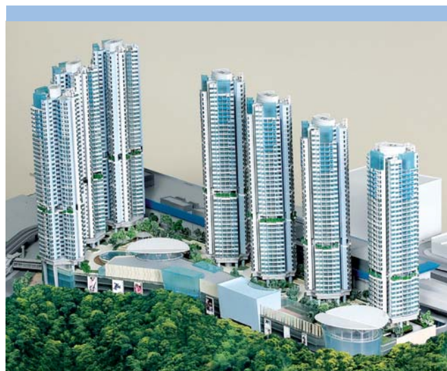
西鐵屯門站發展項目位處完善交通網絡的樞紐。
