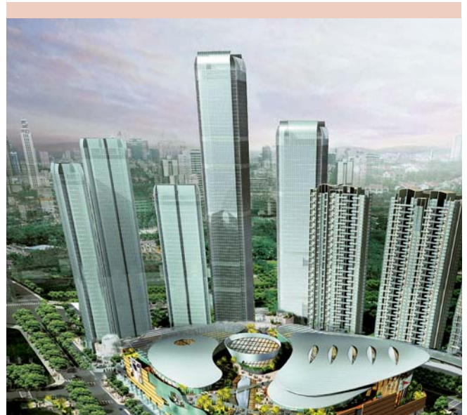
杭州萬象城第一期包括住宅及商場部分，預計於二〇〇九年竣工。
