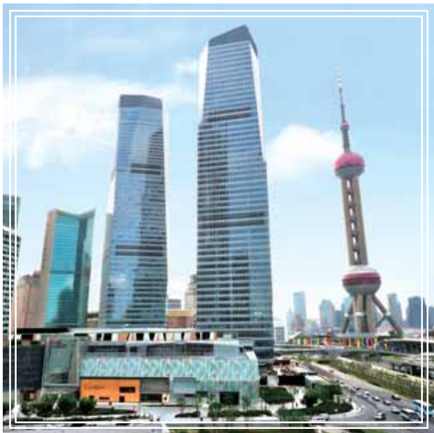
上海國金中心綜合項目雲集頂級寫字樓、商場和酒店，將成為市內的新地標
